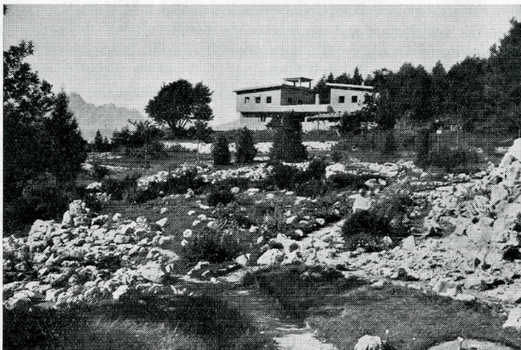
L'edificio che ospiterà il Rifugio della SAT (ala destra), il Laboratorio scientifico (ala sinistra) e l'Osservatorio climatologico (nella torretta in costruzione).
